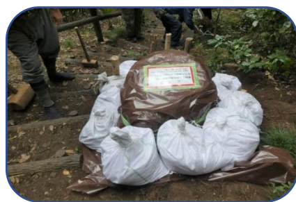
伐採木根本の覆いと土留め設置
