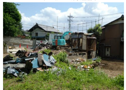
隣接地の角の住宅も解体
