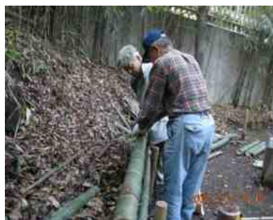
新倉で準備した竹柵用の竹を運び、大坂で落ち葉置き場の作業開始。見事に出来上がり。 間伐のシュロの木も利用して、斜面の土留め兼落ち葉置き場。
