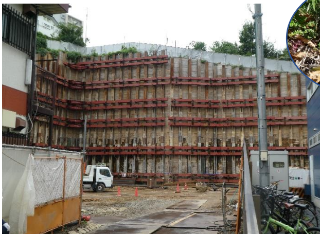
建設が進むかつてのカタクリ自生地 2019 年 9 月
