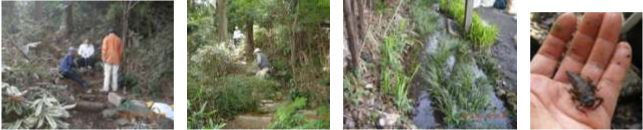
斜めになった石段の修理。上がりやすくなりました。せせらぎづくりの水路づくり。オニヤンマ
